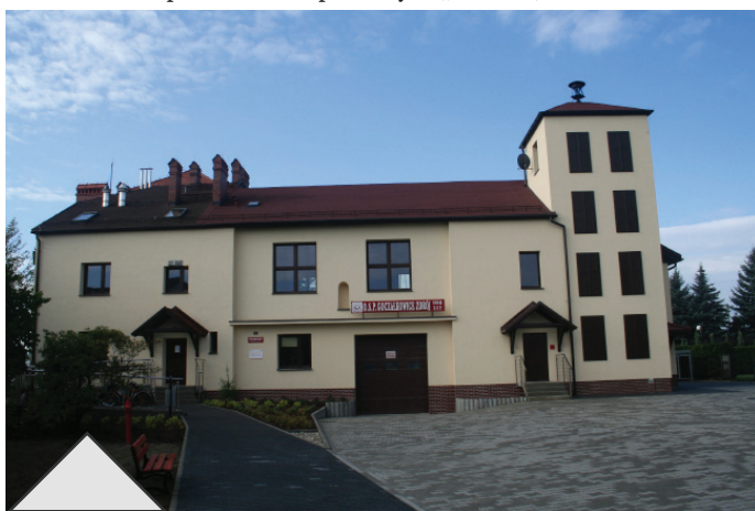
– termomodernizacja starej części budynku Urzędu Gminy przy ul. Szkolnej 13 wraz z dobudową klatki schodowej – m.in. ocieplenie ścian budynku, ocieplenie stropodachu, wymiana pokrycia dachowego, modernizacja wieży wraz z dobudową klatki schodowej, wykonanie pochylni dla niepełnosprawnych, wykonanie wentylacji mechanicznej i klimatyzacji w sali oraz kuchni, – modernizacja oświetlenia ulicznego – wymiana 655 lamp na energooszczędne oprawy oświetleniowe oraz montaż dodatkowych 53 punktów świetlnych.
