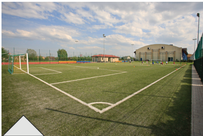
– budowa kompleksu boisk sportowych „ORLIK”,
