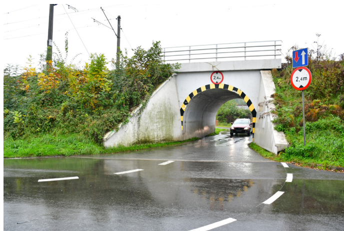
Tunel w ciągu ul. Głównej ma zostać zamknięty dopiero po zakończeniu prac na przejeździe w ciągu ul. Szkolnej (Fot. UG)
