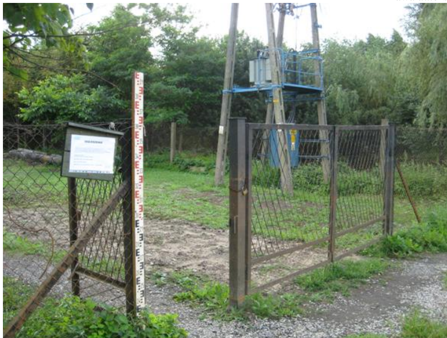
Fot. 6. Tymczasowa lata wodowskazowa terenów zalewowych przy pompowni melioracyjnej, w tle stacja trafo zasilająca obie przepompownie
