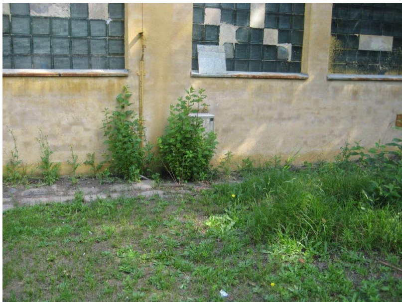
Fot. 4. Skrzynka zasilająca pompownię DK-1 (na ścianie pompowni melioracyjnej)
