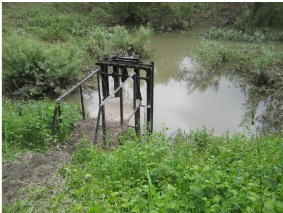
Fot.1a. Zamknięcia istniejącej śluzy w lewym wale Wisły
