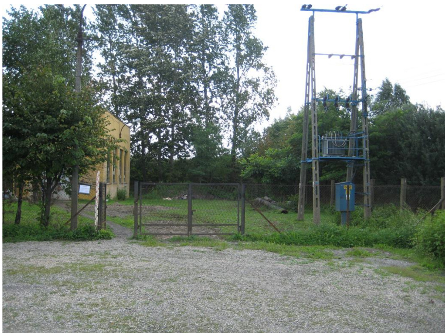
Fot.1. Widok na teren pompowni wód gruntowych
